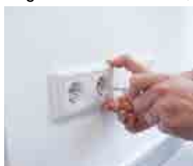
Blenden und Rahmen demontieren
